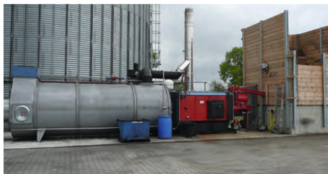
Nepřímý ohřivač vzduchu STELA se spalovacím zařízením Bioflamm
